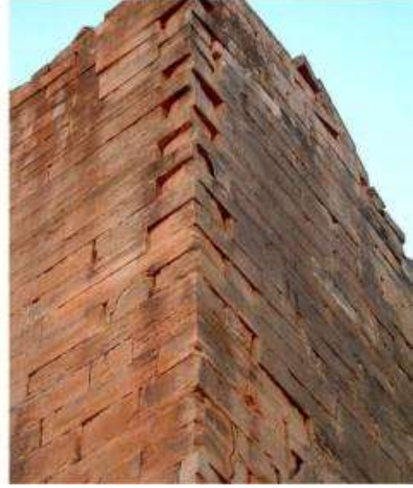
شكل (5) طريقة بناء معبد مدينة يحا باستخدام كتل حجرية مصقولة دون استخدام ملاط للربط بين الكتل. (Asrat 2009, Fig.4)
