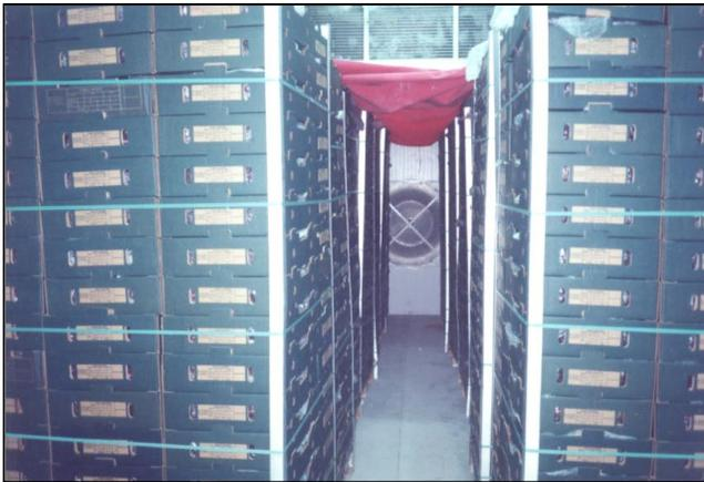
الجوانب وسحبه من الممر الواقع على جانبي صفى البالتات بواسطة مروحة شفط ذات قوة سحب قوية والتي تسبب عند دورتها انخفاضا فى ضغط الهواء بالممر مما يجبر تيار الهواء على الحركة من الضغط العالى (الهواء الخارجى المحيط بالبالتات) الى الضغط الاقل ( هواء الممر الداخلى).
