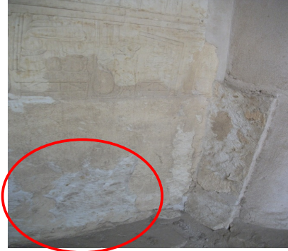
شكل 10- تآكل في وحدات الطوب اللبن في جدار الفناء الخارجى ربما بسبب اصابة حشرية.
