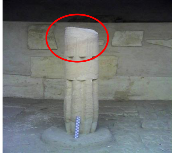
شكل 8- الانهيار الجزئي لأحد الأعمدة (على اليمين) و الانهيار الكلى لأحد الأعمدة و لم يتبقى إلا قاعدته (على اليسار).
