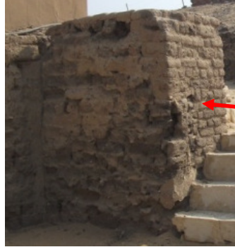
شكل 10- تآكل في وحدات الطوب اللبن في جدار الفناء الخارجى ربما بسبب اصابة حشرية.
