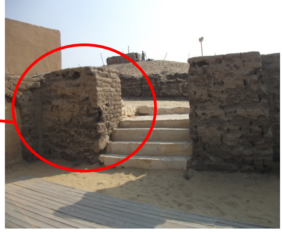
شكل 10- تآكل في وحدات الطوب اللبن في جدار الفناء الخارجى ربما بسبب اصابة حشرية.
