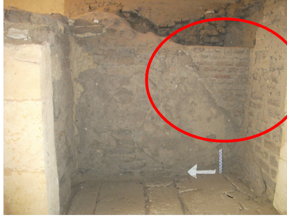
شكل 7- الانهيار الجزئي لأحد الجدران في الحجرة على يمين المدخل و الاستكمال بالطوب الأحمر.
