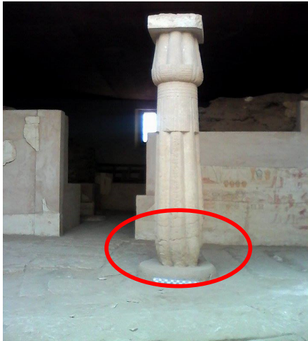
شكل 9-وجود انفصالات فى جزء تم تجميعه من صورة جدارية (على اليمين) ، و وجود شرخ أفقى فى أحد الأعمدة (على اليسار).
